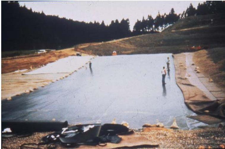
Joonis 5 Lameda lehe ekstrudeerimismeetodil toodetud geomembraan [17]
