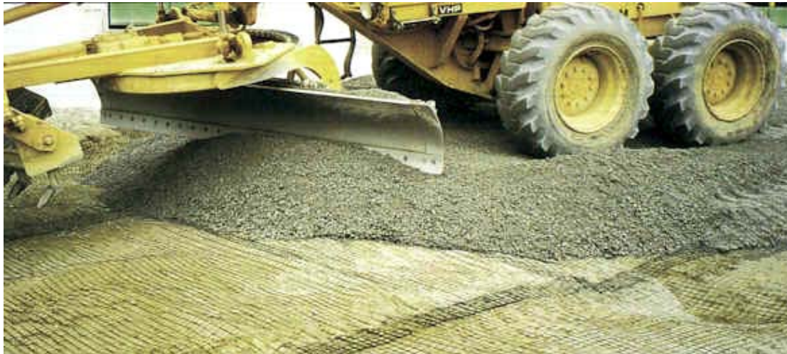
Joonis 25 Mineraalmaterjali laotamine geovõrgule
