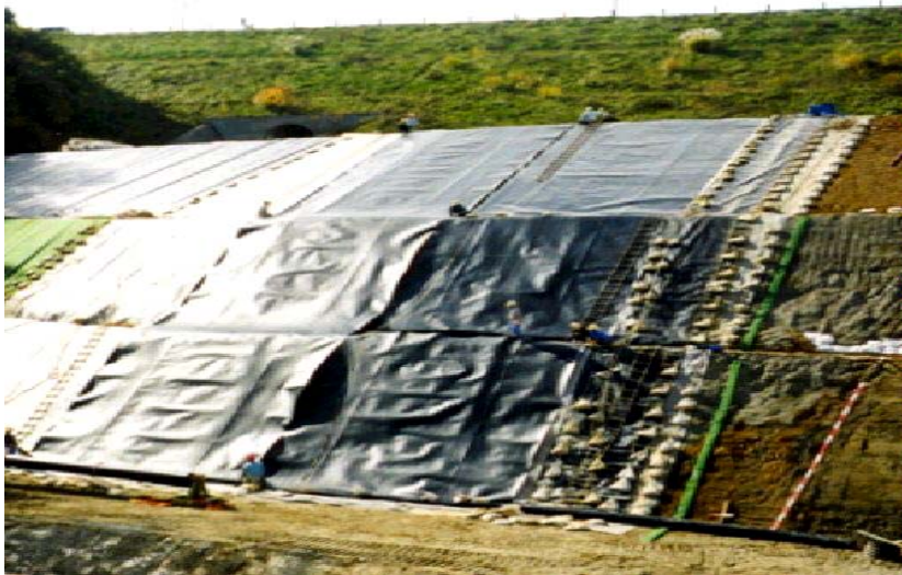
Joonis 6 Puhatud lehe ekstrudeerimismeetodil toodetud geomembraan [17]
