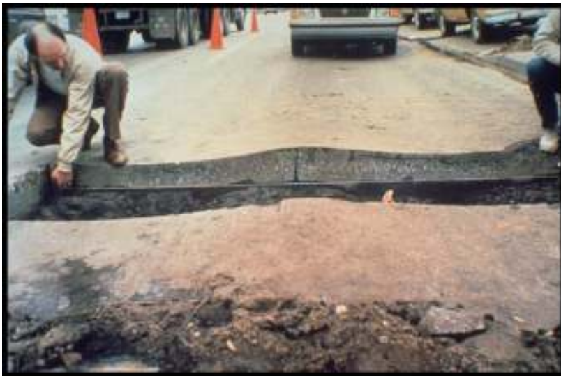
Joonis 6. Osaliselt aluse nihkumisest tekkinud roopad tee pinnas
