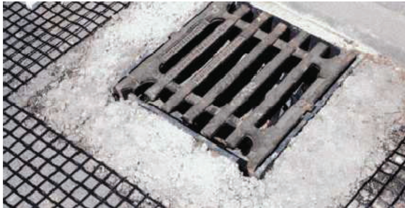
Joonis 47 Restkaevu armeerimine [3]
