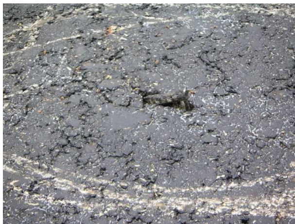
Joonis 49 Väljaulatuv terasvõrgu osa
