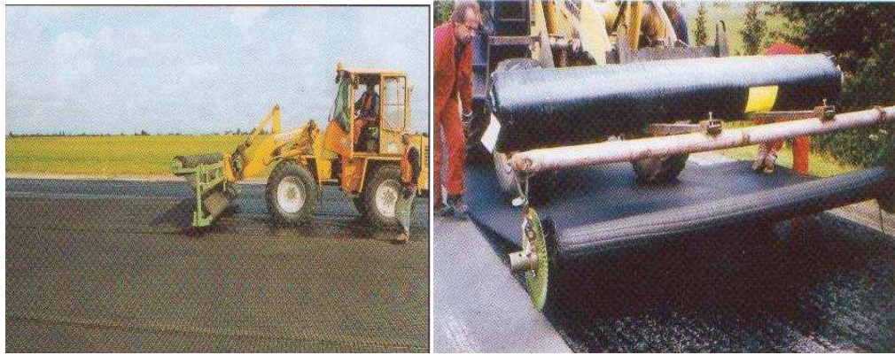
Joonis 42 Asfaldi geovõrgu paigaldamine [6] [7]
