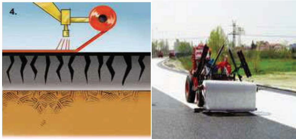
Joonis 36 Geotekstiili paigaldamine [9] [10]
