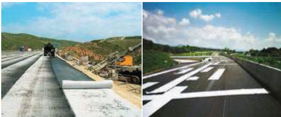
Joonis 37 Paigaldatud geotekstiil [10]
