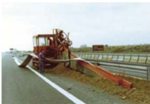
Joonis 33. Liitdrenaaži paigaldamine teepeenra drenaažina
