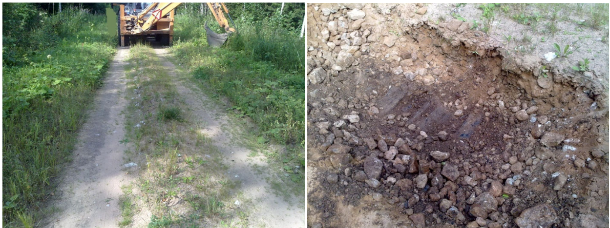
Foto 21 ja 22. Punkri tee teine sirge; surfi kohalt oli tee rajatud puuroigastele. Antud kohas oli ka kandevõime kõikidest mõõtmistest kõige suurem
