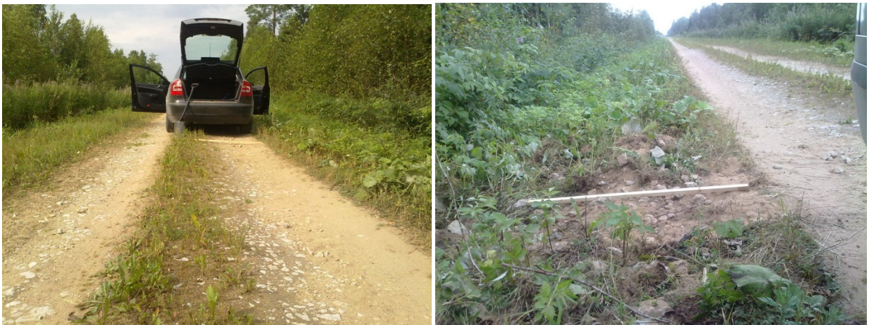
Foto 11. Tee parempoolne serv on ära vajunud Foto 12. Peenralt eemaldatud kasvupinnas
