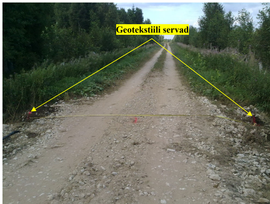
Foto 20. Geotekstiili laius mõõdetuna PK593+20; sõidujäljed paiknevad võrdsetel kaugustel tee tsentrist ja mingeid vajumeid pole
