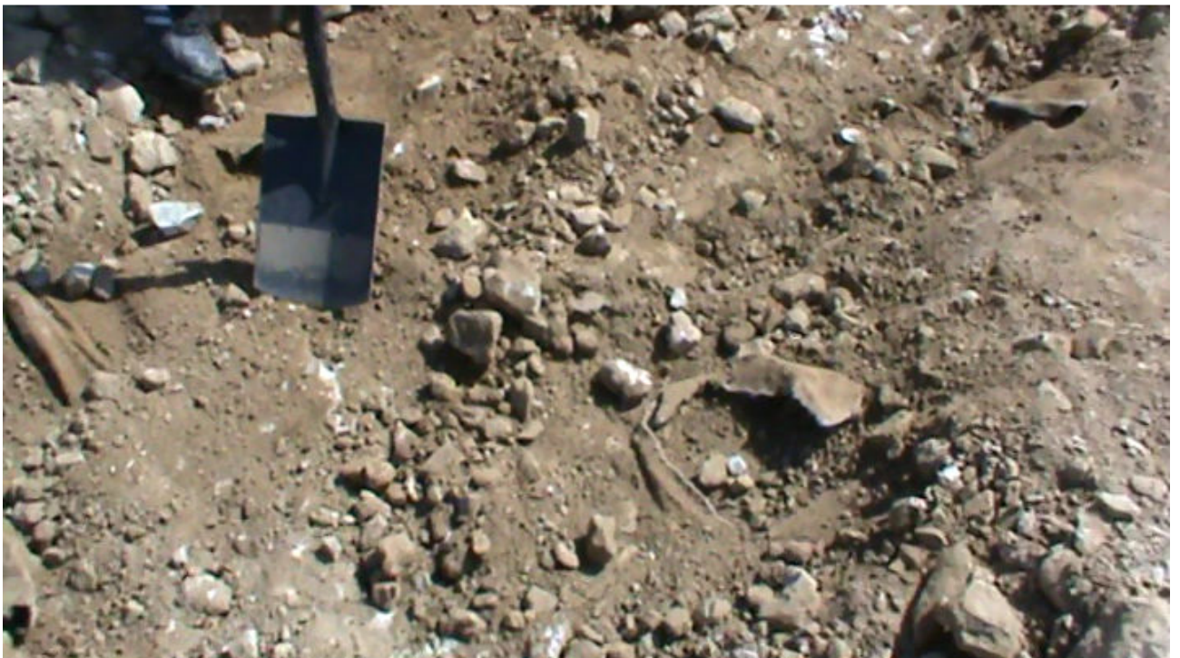
Foto 38. Aluses on meeletu roobas ning kihipaksus olematu. Seetõttu sai geotekstiil kaevamise käigus ka vigastusi
