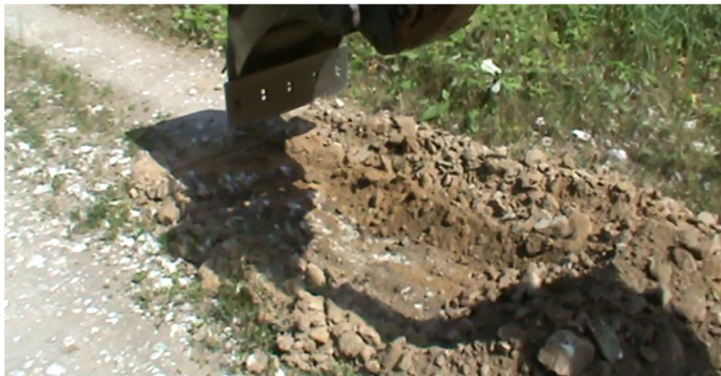
Foto 32. Soojaku tee esimesel sirgel olev surf
