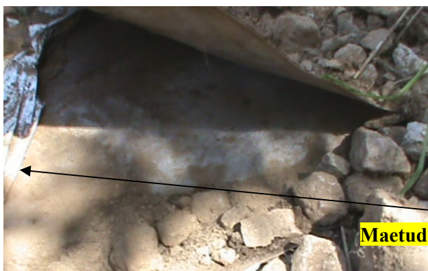
Foto 30. Geotekstiil ülekatte all on nagu uus
