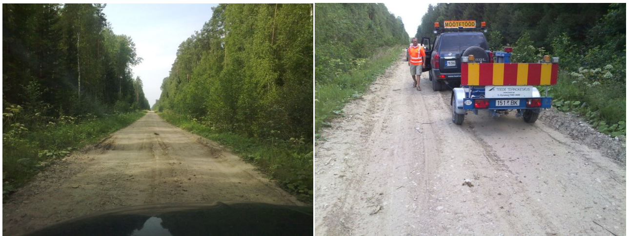
Foto 45 ja 46. Mihklimurru tee oli tugevalt deformeerunud.
