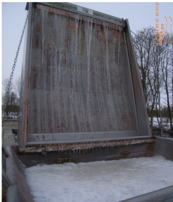
Joonis 1.4. Mehaaniline kaarvõre Vigala Piimatööstuse reoveepuhastil (foto: V.Kõrgmaa)
