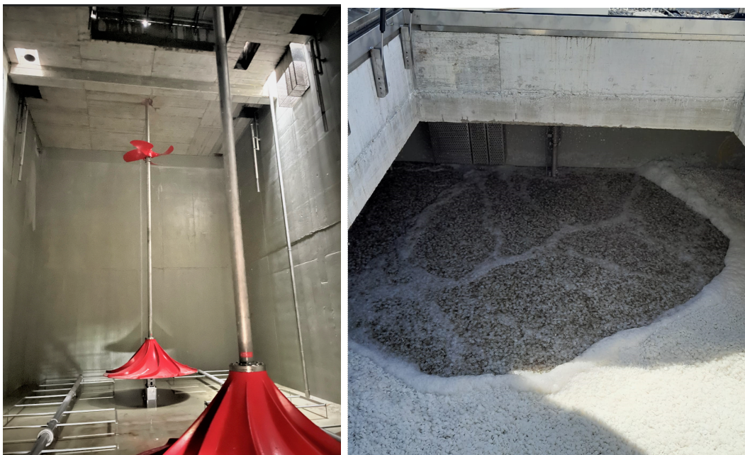
Joonis 2.13. Heljuvbiokilekandjaga reaktori sisevaade (Veolia ANITA™ Mox tehnoloogia) vasakul, paremal foto protsessi käivitamisest Ljubljana reoveepuhastil (foto: V. Lemmiksoo)
