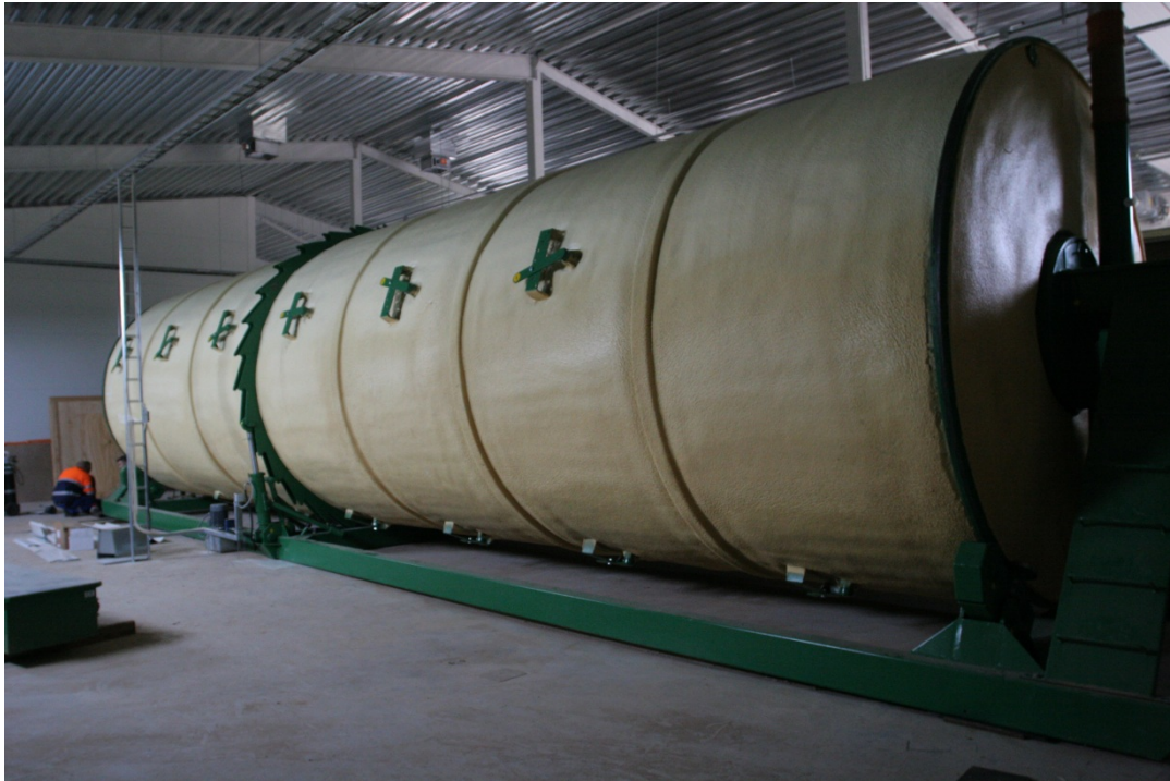
Joonis 17.24. Põlva reoveepuhasti trummelreaktor (Foto: M. Kriipsalu)
