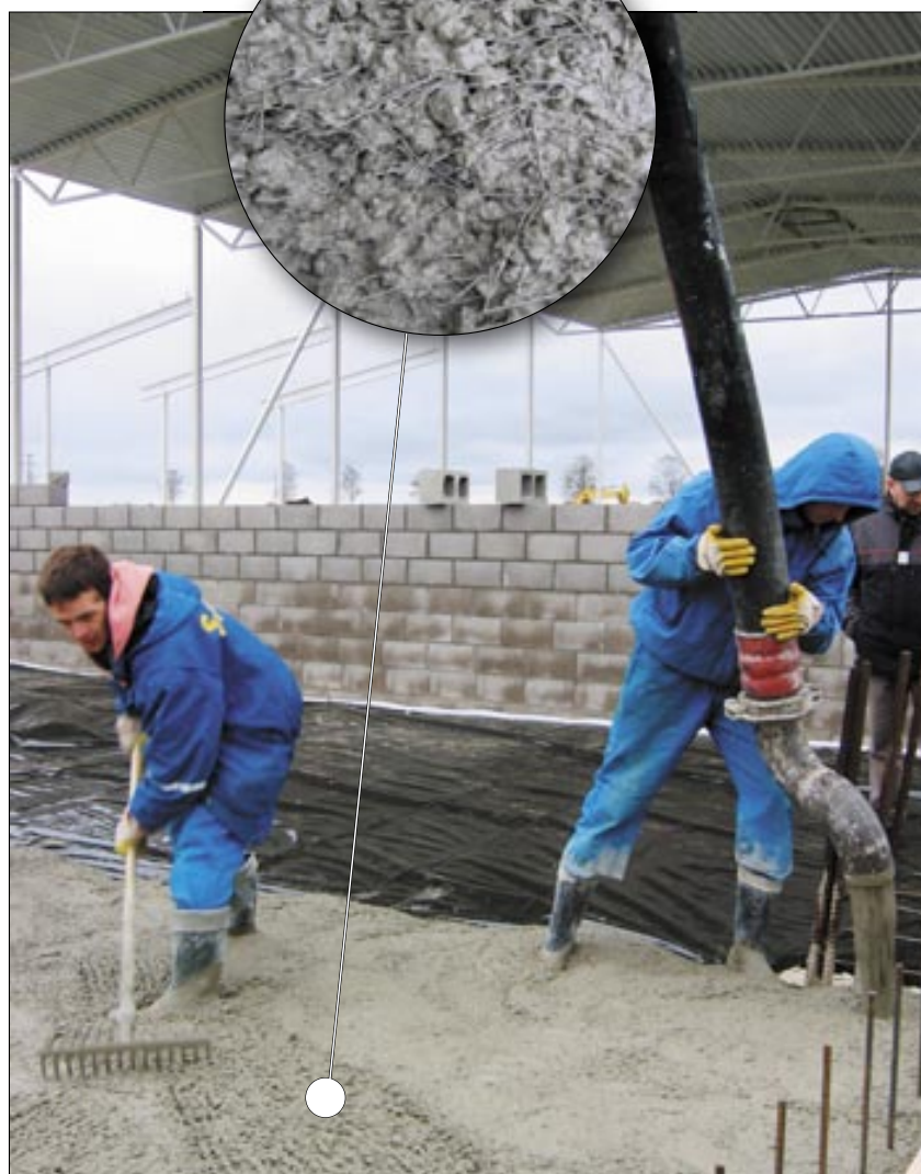
“Armatuur” paigaldatakse koos betooniga.
