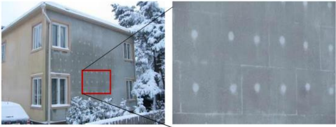
Joonis 4.12 — Soojustuse kinnitite ja soojustusplaatide vaheliste vuukide mõju piirde soojuskadudele
