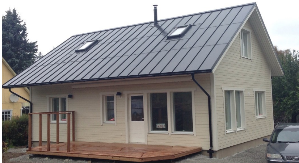
Joonis 7.6. Elektrit tootev valtsplekk-katus ( http://roofit.solar ).
