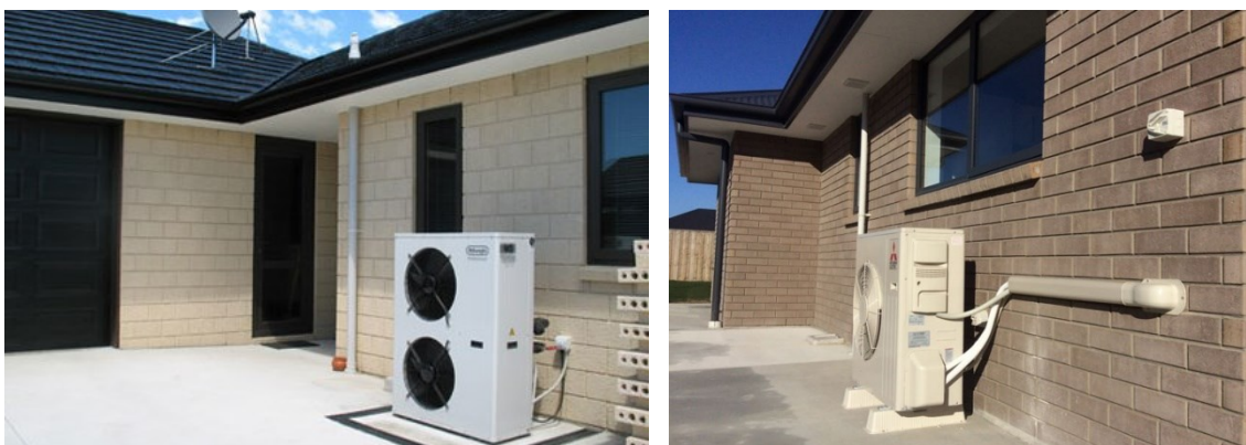
Joonis 6.8. Näited õhksoojuspumba välisosade paigaldusest.
