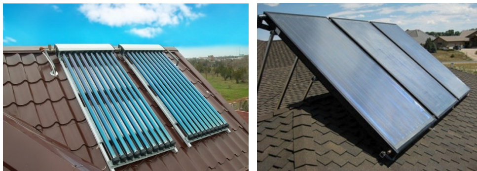
Joonis 7.2. Näited päikesekollektorite paigaldusest katusel: vaakumkollektorid (vasakul) ja lamekollektorid (paremal).
