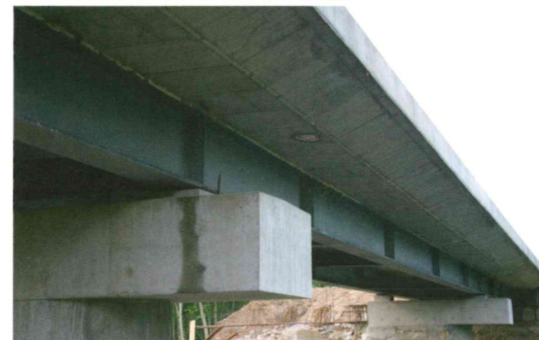
Ehitusel olev Otiveski sild ja selle filmsingitud terastalad
