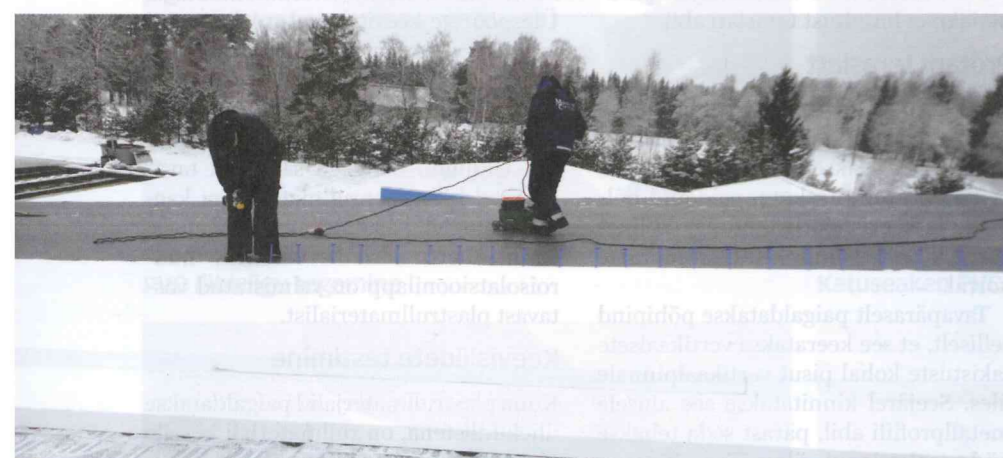
Protan SE paigaldus vahtpolüstüreenile. Katte ja EPSi vahele paigaldatakse klaasvillak.
