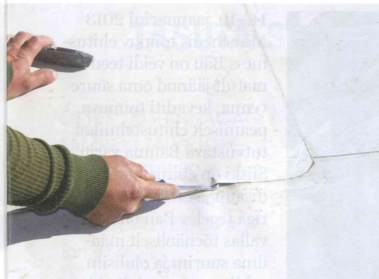
Ülekattevuukide kinnisulamist saab kontrollida spetsiaalse konksuga.
