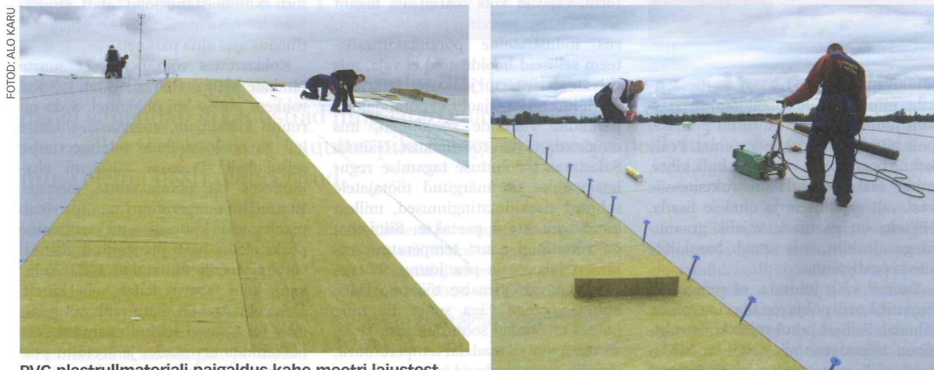
PVC mehaaniline kinnitamine ja vuukide keevitamine
