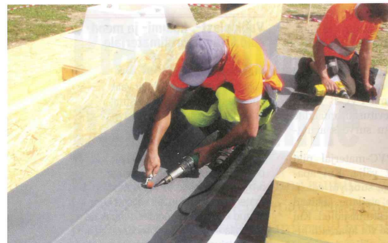
PVC vuukide kinni sulatamine käsifööniga
