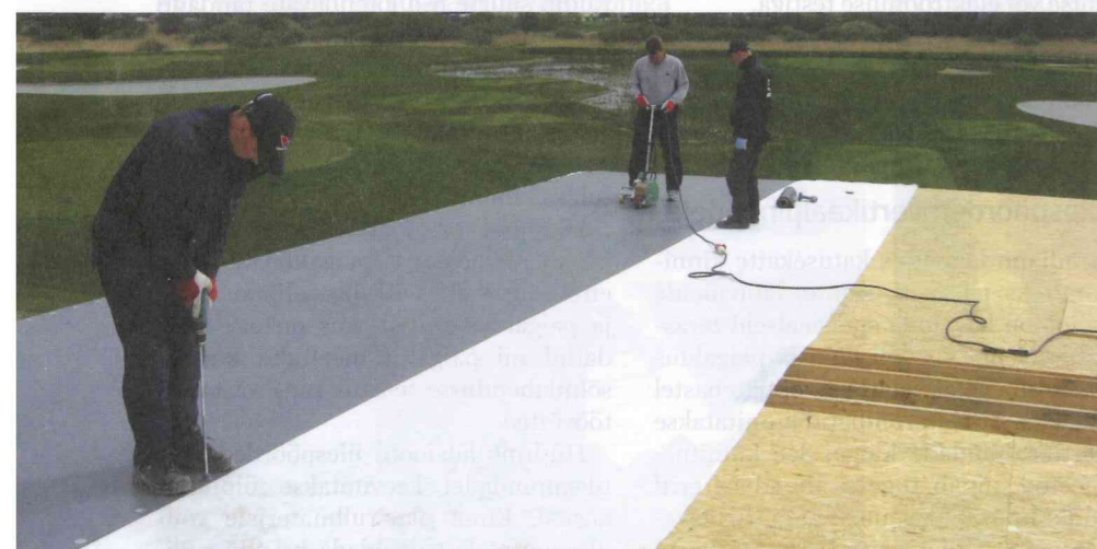
Protan SE paigaldus OSB-plaadile. Vahele käib klaasvillak.
