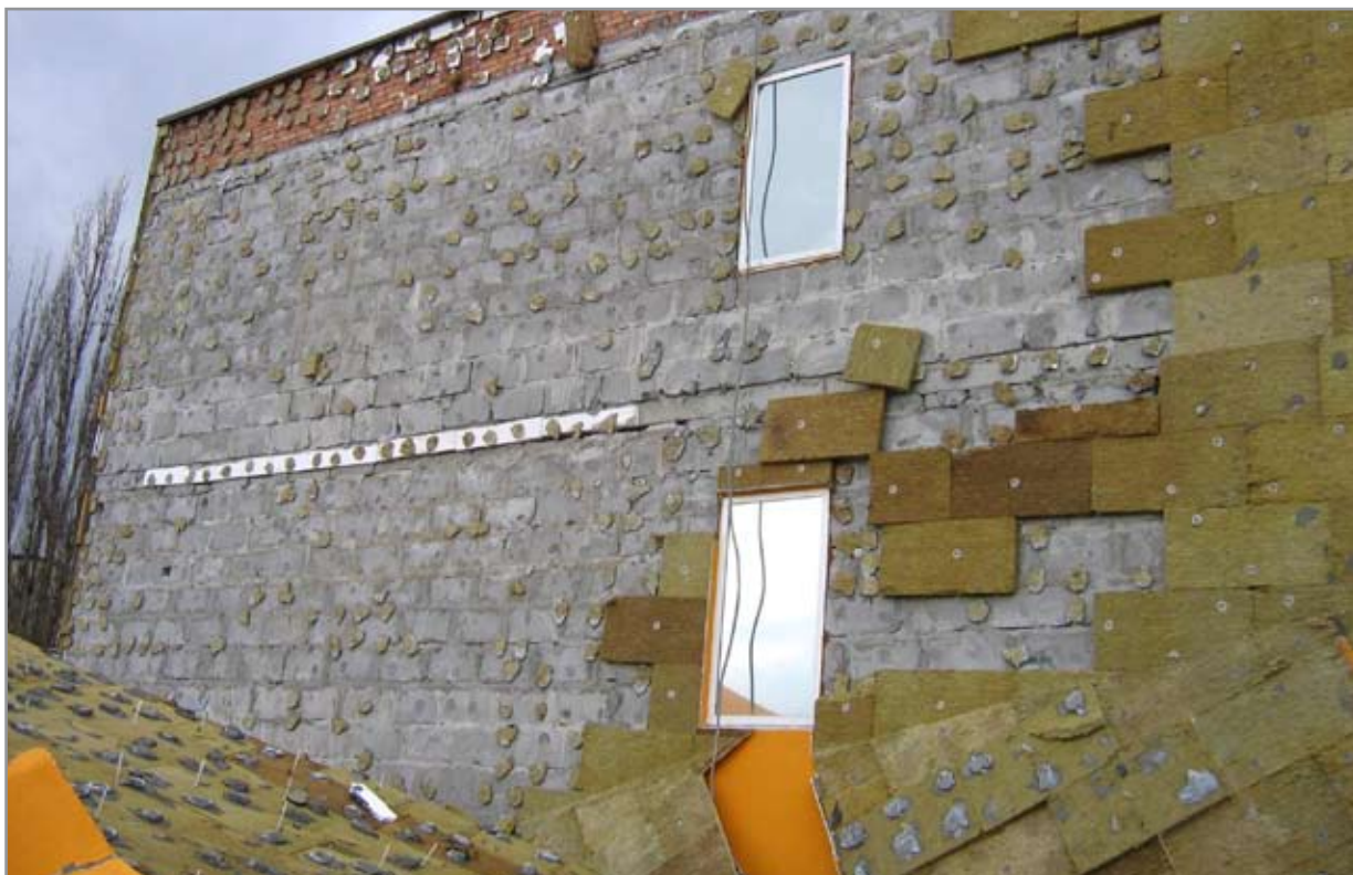
Pilt 1. Valesti paigaldatud fassaadiplaadid on seina küljest tuulega lahti tulnud ja alla kukkunud.
