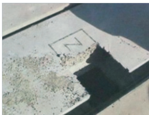
Joonis 8.9 - Tõstekaeluse märgistus paneelil
