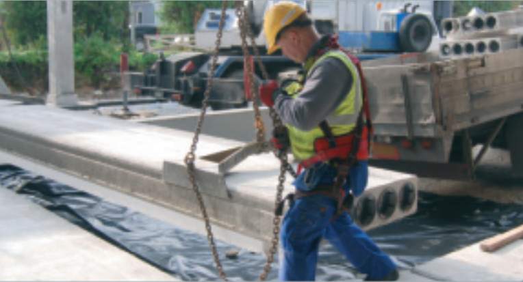
Joonis 8.5b – Haaratsi eemaldamine õõnespaneeli küljelt
