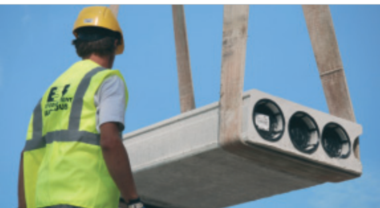
Kitsa paneeli tõstmine tõsterihmadega
