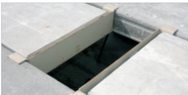
Joonis 8.16 – Terasest vekseltala paneeli toestamiseks
