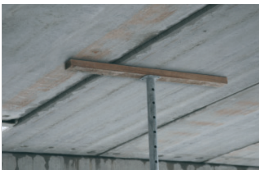
Joonis 8.13 - Kaardumiserinevuse ühtlustamine püsttoega paneeli teise ribi kohal
