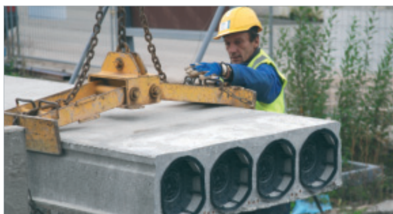
Joonis 8.5a – Haaratsi paigaldamine õõnespaneeli külge ja ohutusketi kinnitamine
