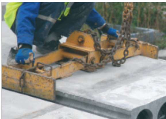
Joonis 8.5a – Haaratsi paigaldamine õõnespaneeli külge ja ohutusketi kinnitamine
