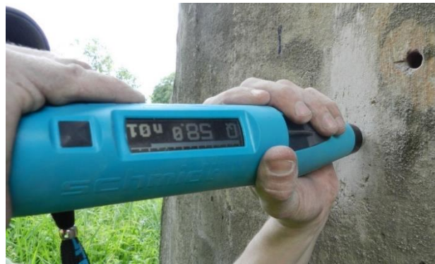
Foto 28. Betooni survetugevuse kaudne hindamine mittepurustava katsetamisega
